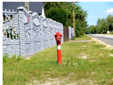
Kuźnica Grodziska Budowa sieci wodociągowej z przyłączami
