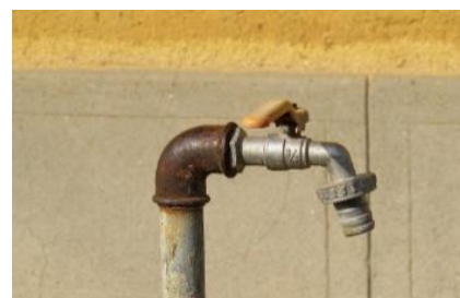
Zakończona budowa sieci wodociągowej z miejscowości Teresów do miejscowości Załęże Dofinansowanie - dotacja z rezerwy celowej Budżetu Państwa
