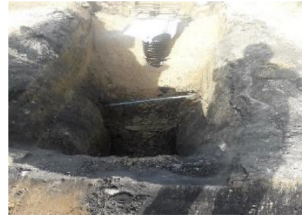
Zrealizowana kanalizacja sanitarna na ulicy Słowackiego
