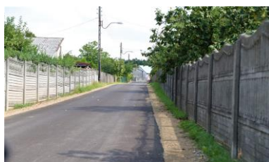
Koniecpol Przebudowa ulicy Piaskowej
