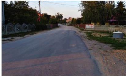
Luborcza Remont drogi - ulica Leśna
