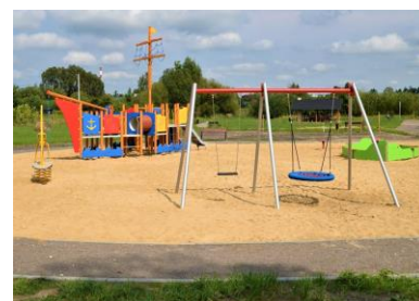
Konieczpol Zagospodarowanie terenu obok zalewu budowa placu zabaw
