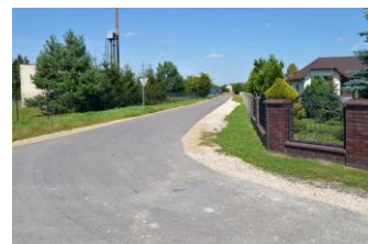
Rudniki Remont drogi obok szkoły
