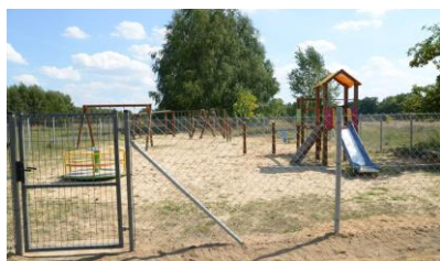
Aleksandrów Budowa ogrodzenia placu zabaw
