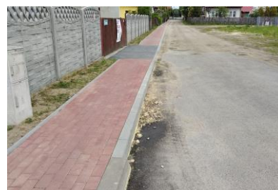
Koniecpol Remont chodnika przy ulicy Stawowej
