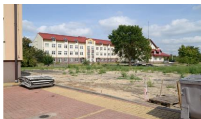
Koniecpol Przygotowanie terenu przed budynkiem UMiG przed rozbudową miejsc postojowych
