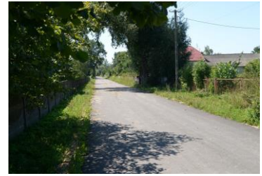
Luborcza Remont drogi - ulica Łąkowa
