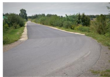
Koniecpol Remont ulicy Rzecznej
