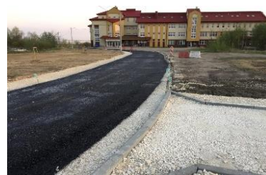
Koniecpol Budowa drogi dojazdowej do Miejskiej Przychodni
