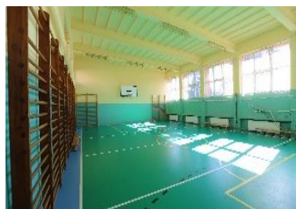
Remont hali sportowej
