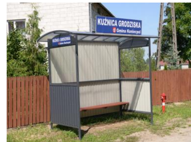
Kuźnica Grodziska Budowa przystanków
