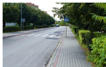
Koniecpol Remont chodnika przy ulicy Robotniczej
