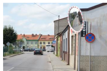
Koniecpol W celu poprawy bezpieczeństwa na skrzyżowaniach – montaż luster drogowych
