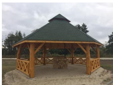
Koniecpol Budowa dodatkowych altan nad zalewem
