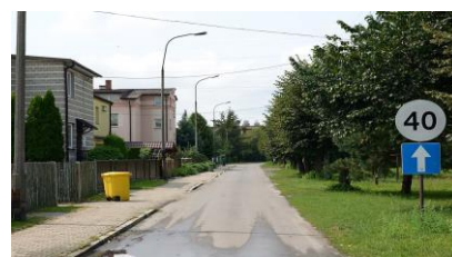
Konieczpol Remont nawierzchni ulicy Ogrodowej
