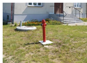
Rudniki Budowa sieci wodociągowej z przyłączyami
