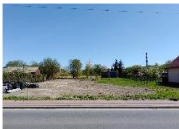
Porządkowanie terenów - wyburzenie zdewastowanego budynku, powstanie drogi dojazdowej na tzw. „Księdza Pole”
