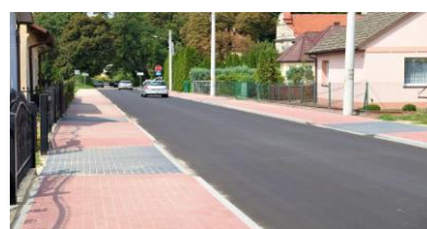
Konieczpol Przebudowa ul. Zamkowej
