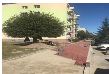
Budowa chodnika na ulicy Robotniczej
