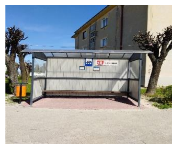
Budowa zadania przystanku na ulicy Robotniczej
