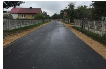
Okołówce Remont drogi - ulica Niwa
