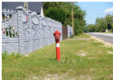
Załęże Budowa sieci wodociągowej
