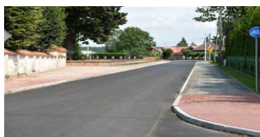
Konieczpol Przebudowa ul. Chrzęstowskiej
