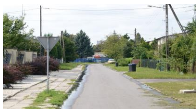
Konieczpol Remont nawierzchni ulicy Działkowej
