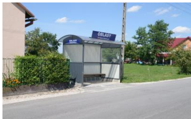
Oblasy Budowa przystanku
