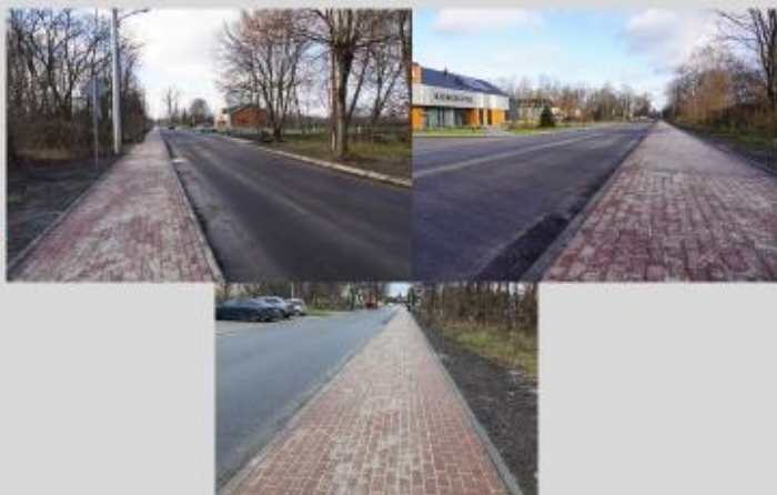
ul. Chrząstowska (od ul. Zamkowej do ul. Nad Brudną Wodą)
