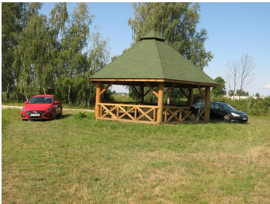
Na terenie przyległym do zbiornika na dojściu do jazu wpustowego znajduje się wiata z wydzielonym miejscem do grillowania
